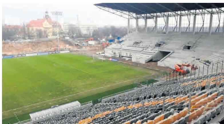
Koszt całej inwestycji to 364,4 mln zł, z czego realizacja stadionu pochłonie 261,2 mln zł
