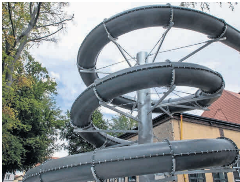
Po przebudowie pływalnia będzie miała między innymi zjeżdżalnię rurową
