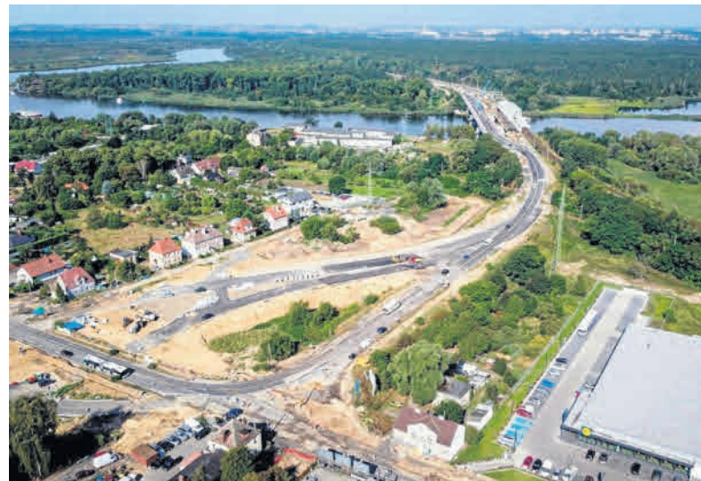
Wykonawca nie będzie czekać do lata z oddaniem inwestycji w całości - poszczególne etapy mają być przekazywane użytkownikom sukcesywnie
