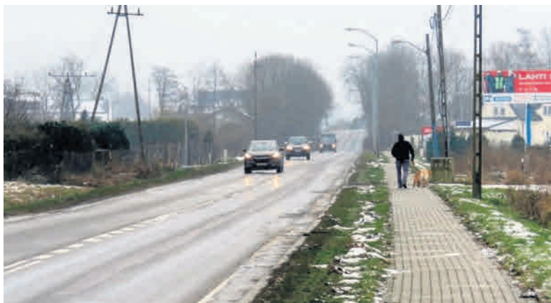
Czekają nas utrudnienia z przejazdem przez Przęsocin. Termin zakończenia prac to koniec kwietnia przyszłego roku
