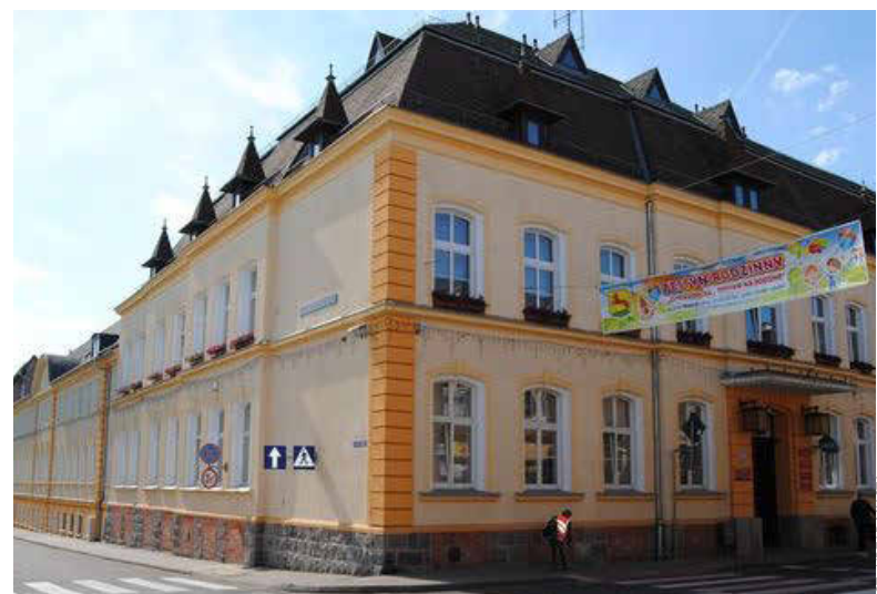
Łobez uzyskał rządowe wsparcie m.in. na wymianę pokrycia dachowego budynku urzędu miasta
