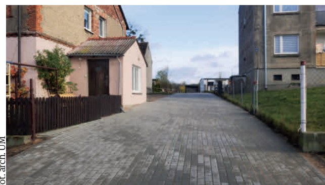
Świąciechów, przebudowa drogi wewnętrznej.
