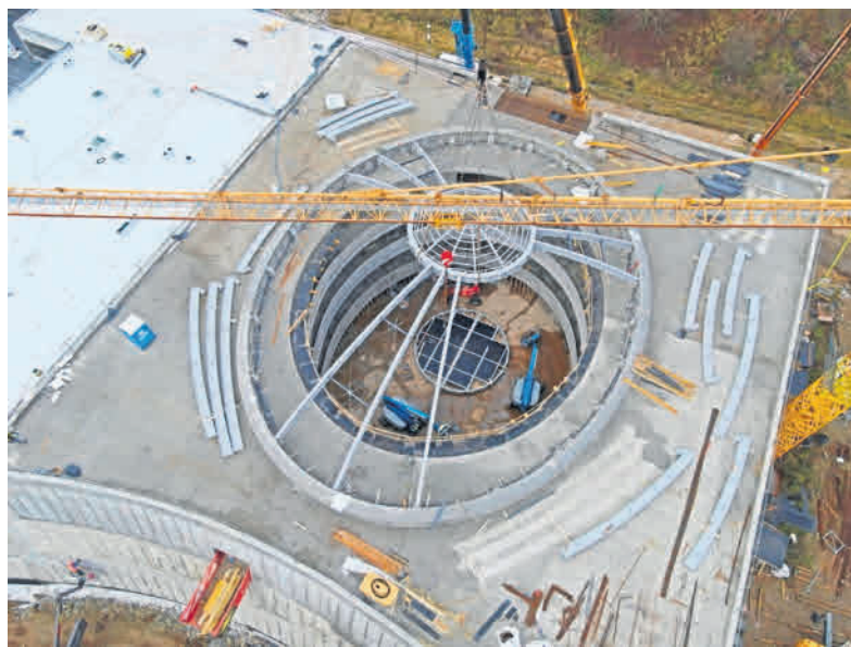
Fabryka Wody przy ulicy Szanieckiej ma być gotowy w drugiej połowie 2022 r.
