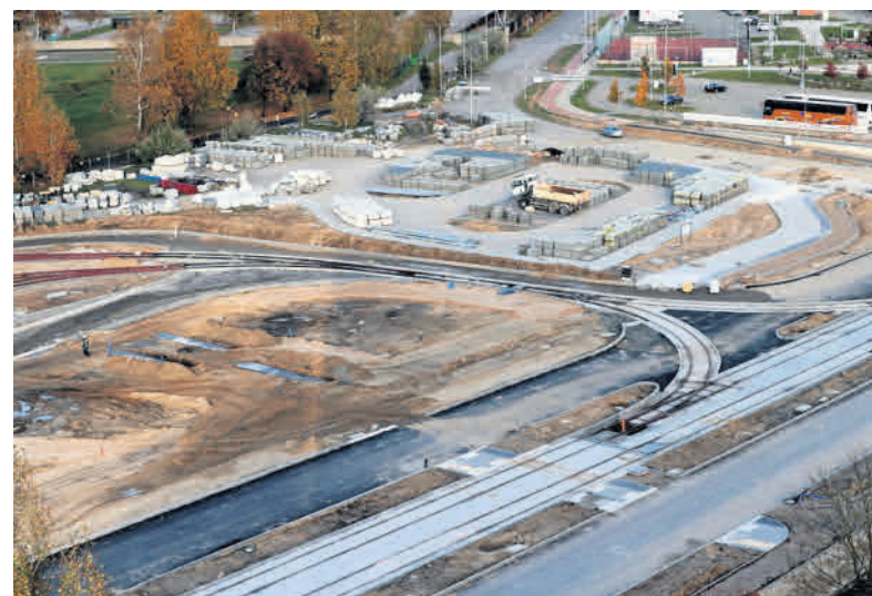
Przebudowa ulicy Szafera trwa nieco ponad rok. W tym czasie pojawiły się już nowe jezdnie, chodniki i torowisko
