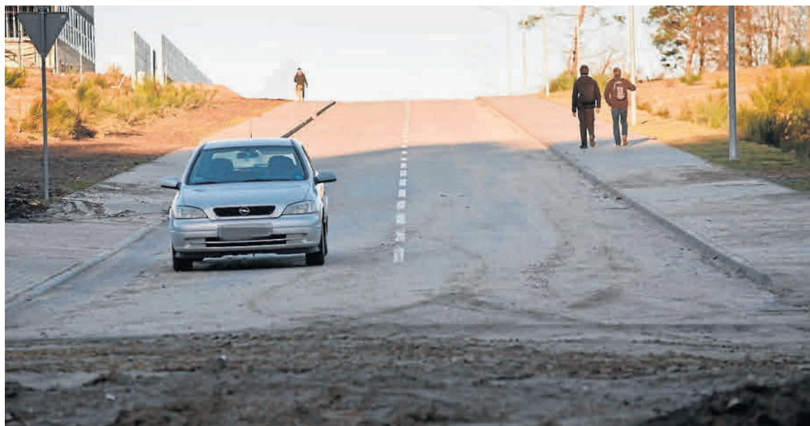
Większa strefa w Płaszewku i nowa droga do Słupska. Gmina ocenia oferty
