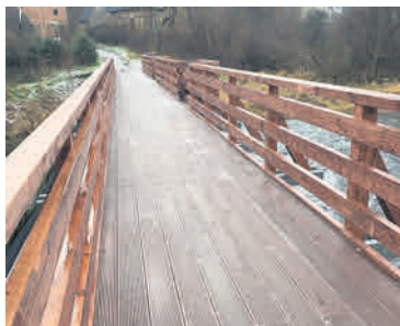
foto. mostek drewniany
