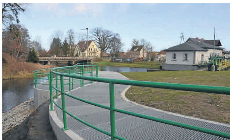
Po zakończeniu budowy. Przepławka dla ryb na Łupawie w Smołdzinie jest przepławką ryglową
