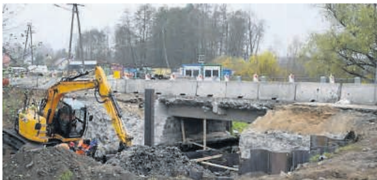
Przebudowa mostu w Tuchomiu w ciągu drogi krajowej nr 20
