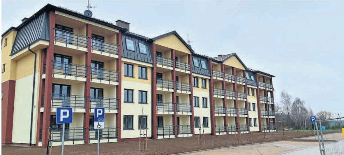
Zarządcą nowego budynku jest Gminne Towarzystwo Budownictwa Społecznego
