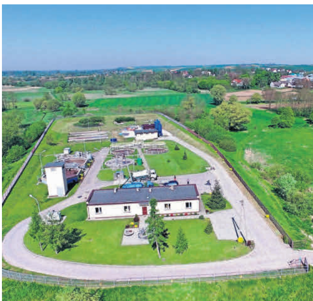
Nowoczesna oczyszczalnia ścieków w gminie Koszyce
