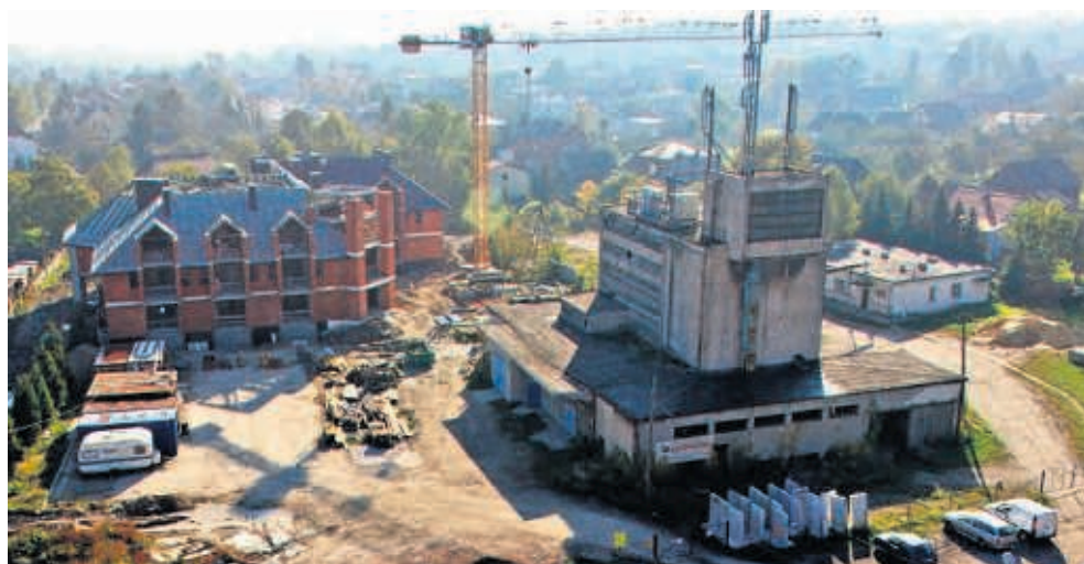
Tak wyglądała budowa Ratusza i Rynku w Zabierzowie, w miejscu dawnego przedsiębiorstwa
