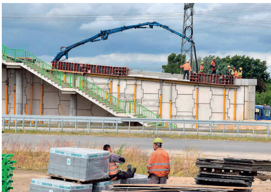
Budowa kładki dla pieszych nad obwodnicą Szczecinka na stacji kolejowej Chyże
