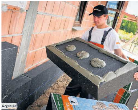
Grubość izolacji termicznej to nawet 30 cm grafitowego styropianu
