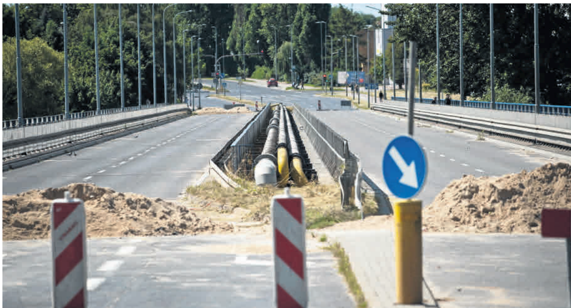
Wiadukt w Koszalinie na razie jest zamknięty dla ruchu. Będzie rozebrany, a budowa nowego pochłonie około 30 mln zł
