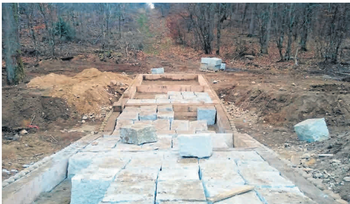
Brody zaprojektowano w konstrukcji kamienno-drewnianej; w ramie układany jest tu kamień grubości około 30-50 cm.
