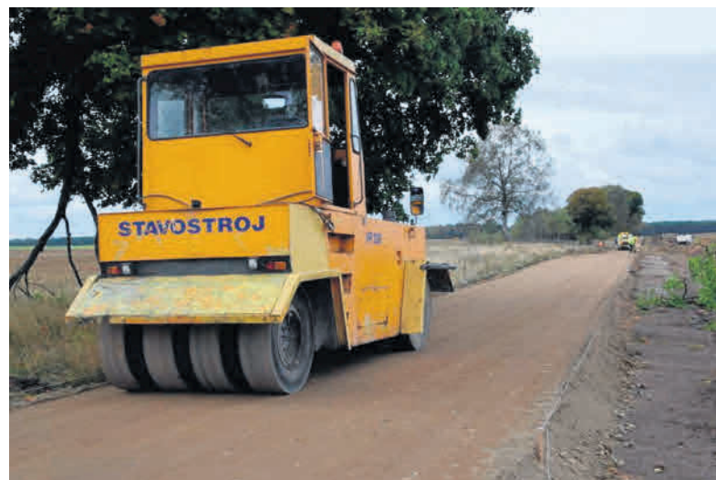
Inwestycja w wiatraki XXI wieku rozpoczęła się od budowy dróg dojazdowych w gminie Biały Bór
