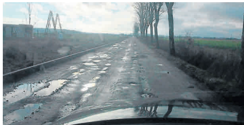
Remontowana droga Mścice - Dobiesławiec. Końcowy odcinek jest jeszcze w dramatycznym stanie. Cała droga ma być gotowa w czerwcu
