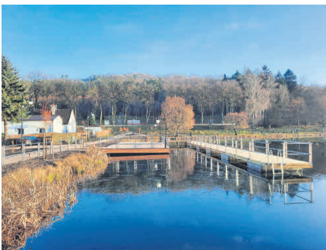
Oficjalne otwarcie wyremontowanego pomostu planowane jest na wiosnę bieżącego roku.
