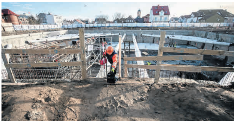
Poziom minus dwa apartamentowca VistaMar. Tutaj powstaje ogromny podziemny garaż
