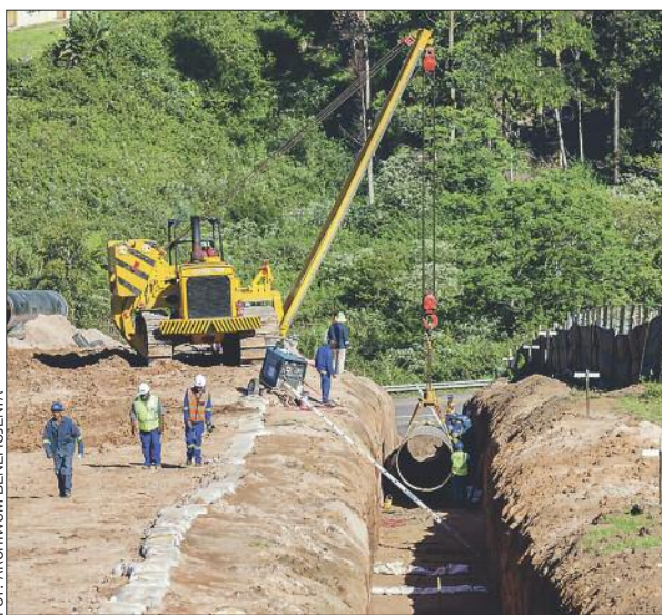
Prawie 90 mln zł wesprze budowę kolejnych sieci kanalizacyjnych.
