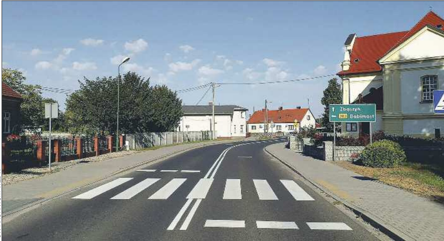
Po przeprowadzonych w latach 2017-2018 remontach droga nr 303 w gminie Siedlec prezentuje się coraz efektywniej.
