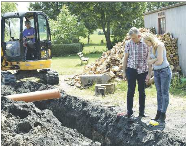
Wójt gminy Tarnówka Jacek Mościcki dostrzegł budowę przydomowych oczyszczalni ścieków w Tarnowcu.
