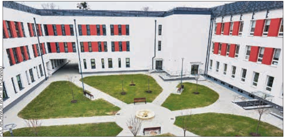
Budowa i wyposażenie nowego skrzydła WCPiIT kosztowały 33,5 mln zł.
