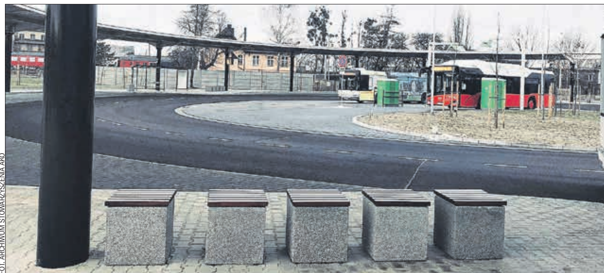
Centrum przesiadkowe w Ostrowie Wlkp. obsługuje obecnie ponad 300 odjazdów dziennie w ramach 24 linii autobusowych.
