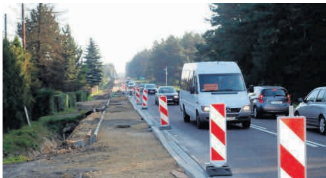
Chodnik w Zarzeczcu II etap w realizacji
