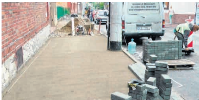
Budowa chodnika na ul. Piłsudskiego w 2015 r.
